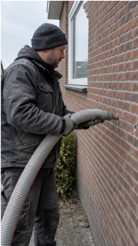
ILLUSTRATIE (AI) Een monteur blaast isolatiemateriaal via een geboord gat in de spouw.
